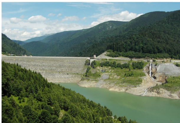
Figura 1.3. Barajul Gura Apelor
