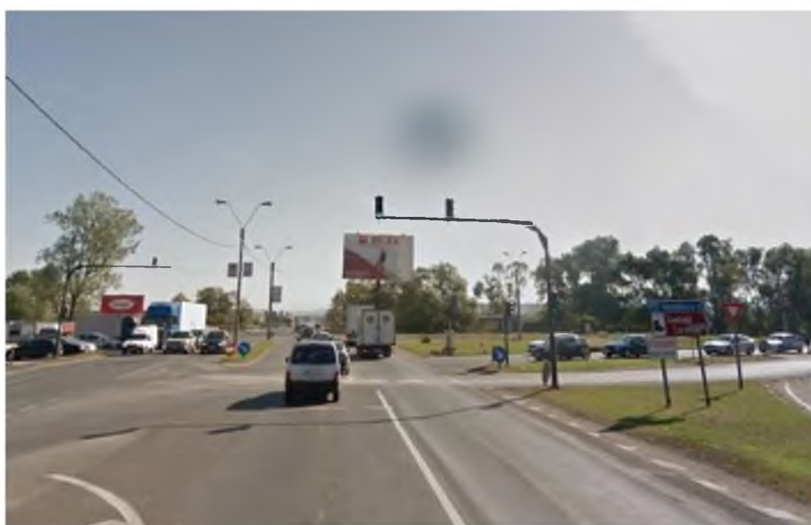
Figura 3.16. Intersecția DN 7 – DJ 687 spre Hunedoara, sens Deva - Simeria, marcaje șterse. Sursa: Google Maps.
