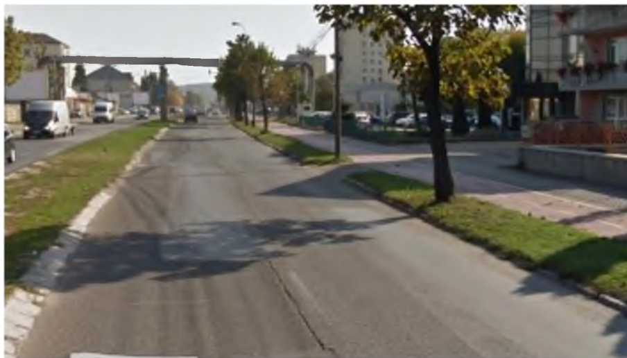
Figura 3.30. Exemplu pistă pentru cicliști pe Calea Zarandului. Sursa: Google Maps.
