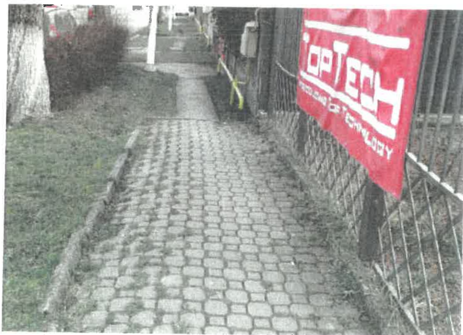
Foto 14. Trotuar dreapta foarte neomogen (pavaj, asfalt, neamenajat)
