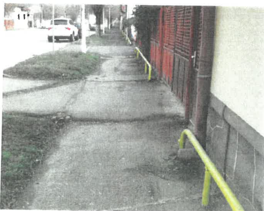
Foto 10. Conductă de gaz în lungul trotuarului, în gabaritul acestuia
