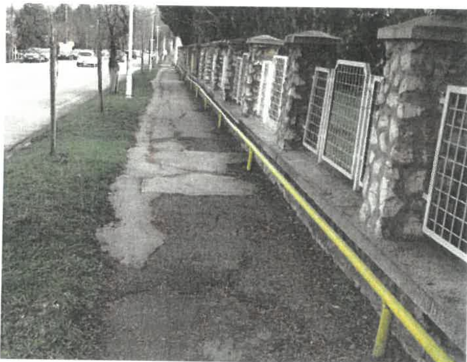
Foto 13. Trotuar dreapta cu îmbrăcăminte de diverse tipuri îmbătrânită
