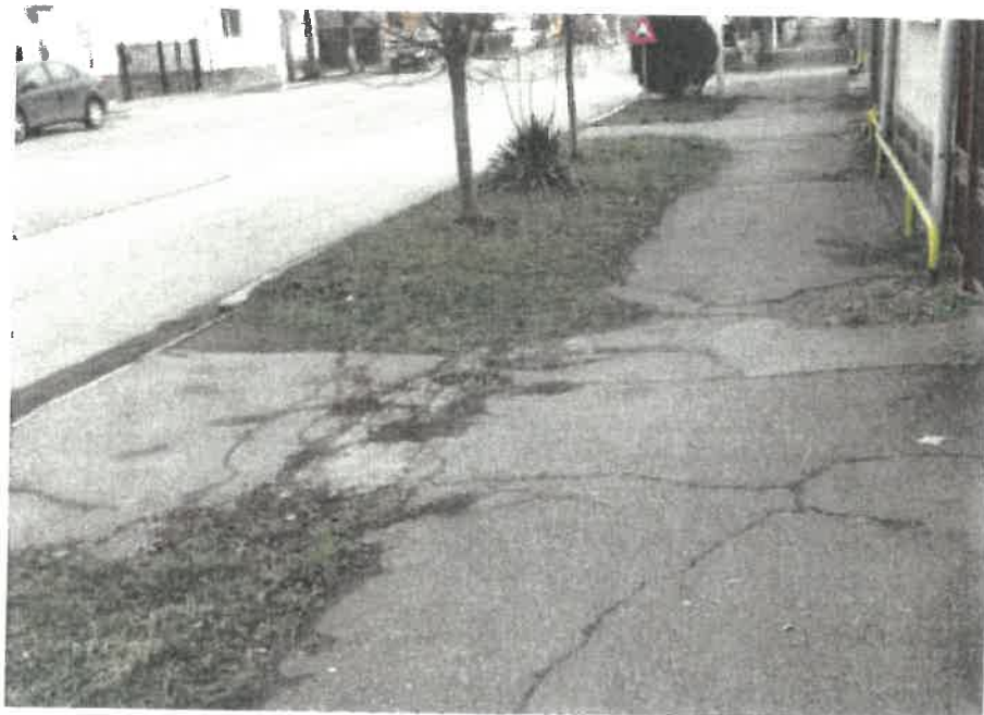
Foto 7. Acces degradat la trotuar dreapta
