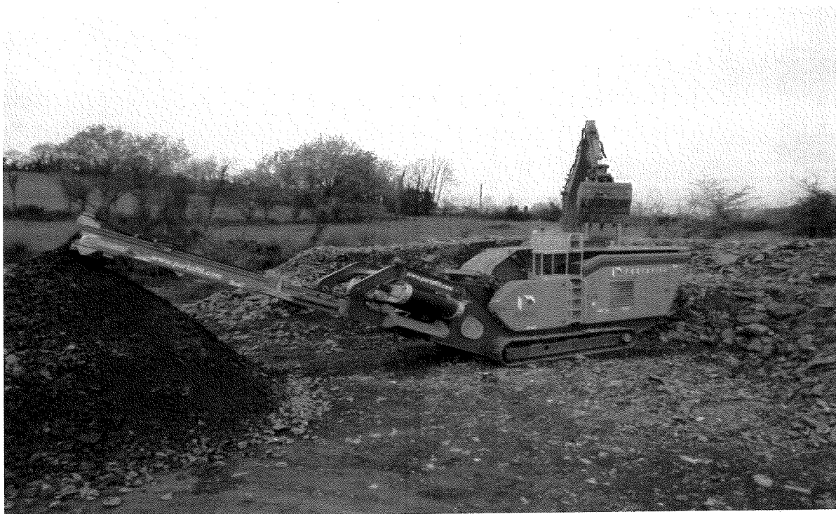
Fig. nr. 6 Instalații mobile de tratare a deșeurilor din construcții și demolări
