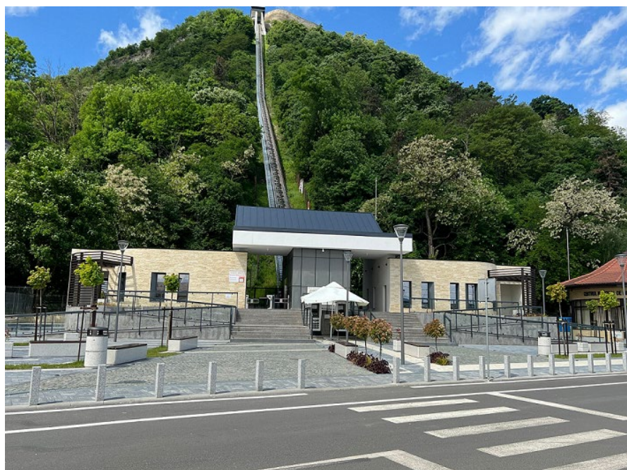
Modernizare ascensor inclinat acces Cetate
