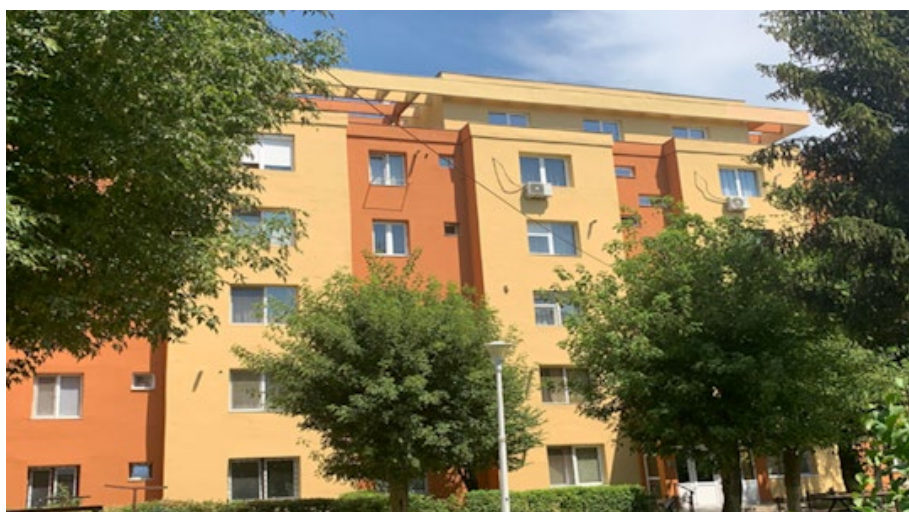
Blocul 7 - Al. Plopilor
