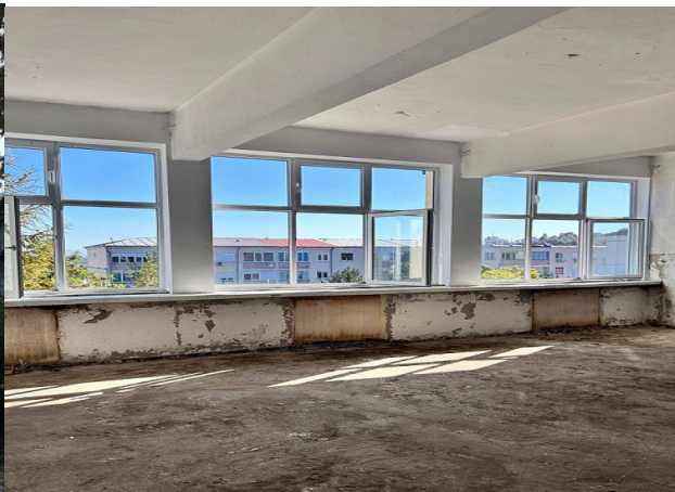
Renovarea energetică a Școlii Generale situată pe strada Bejan, nr.10 aparținând Liceului Tehnologic Energetic Dragomir Hurmuzescu
