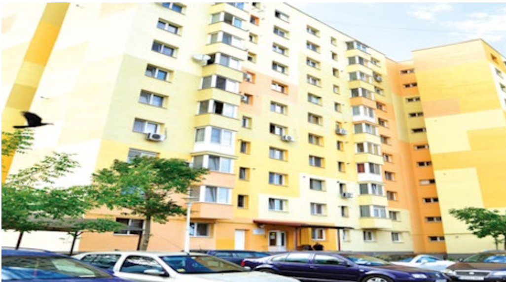
Blocul 79 - Str. Bejan
