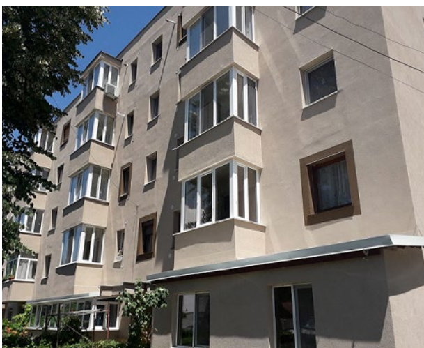
Blocul P3 - Al. Moșilor
