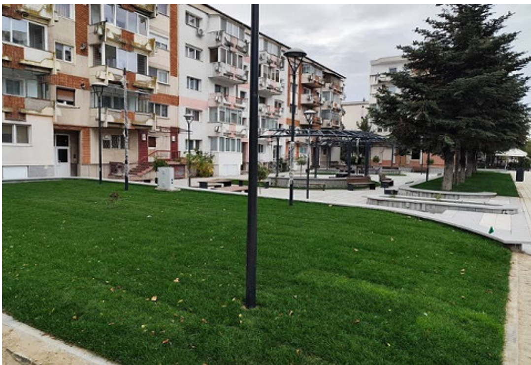
Amenajare platforme pe Bulevardul 22 Decembrie, blocurile 6 și 8
