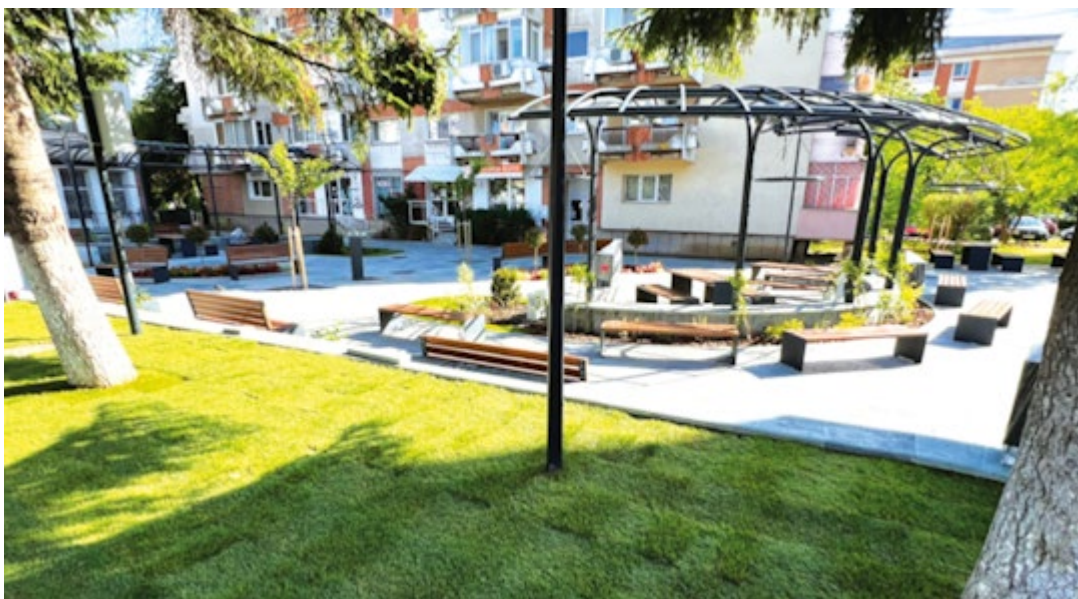
Amenajare platforme pe Bulevardul 22 Decembrie, blocul 10
