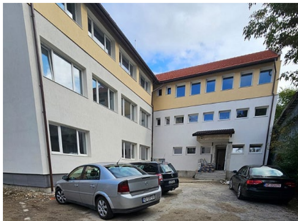
Reabilitarea, modernizarea și echiparea infrastructurii educaționale antepreșcolare la Creșa Deva, Al. Viitorului
