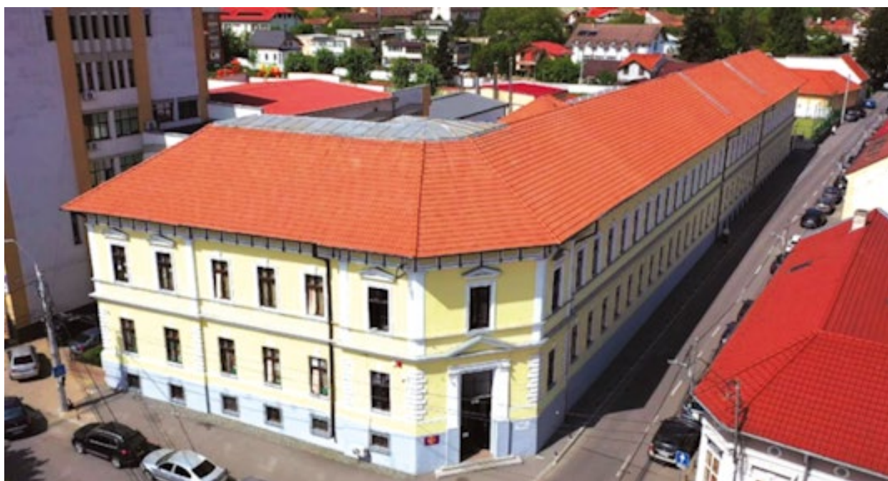
Reabilitarea, modernizarea clădirilor și echiparea infrastructurii educaționale a Colegiului Național Pedagogic „Regina Maria”
