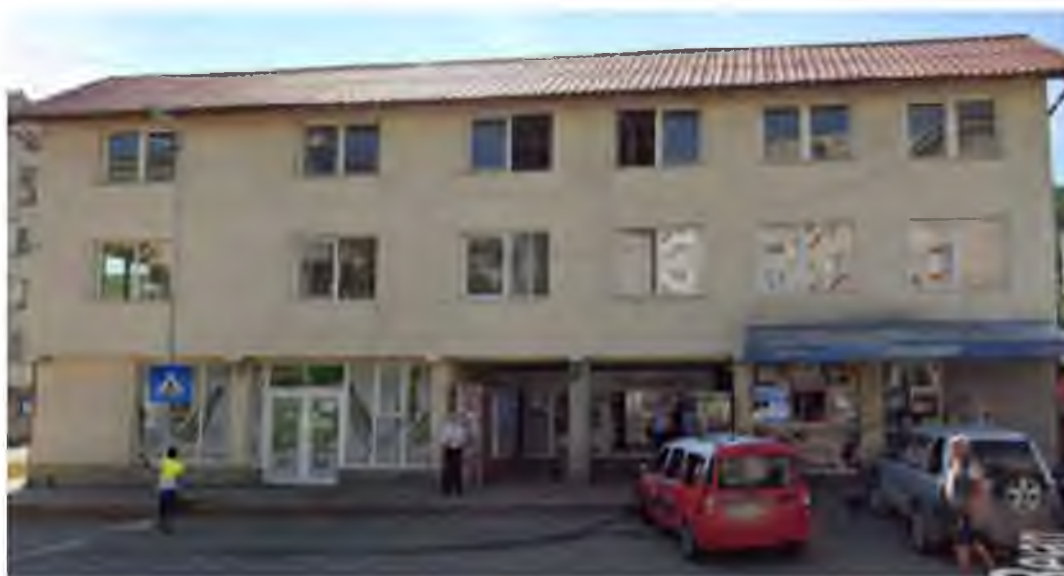
Zona reglementată prin PUD aprobat cu HCL nr. 402/2008. sursă: Google Earth
