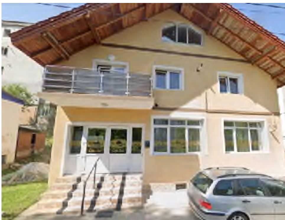
Construcție edificată în baza PUZ aprobat cu HCL nr. 433/2001. sursă: Google Earth
