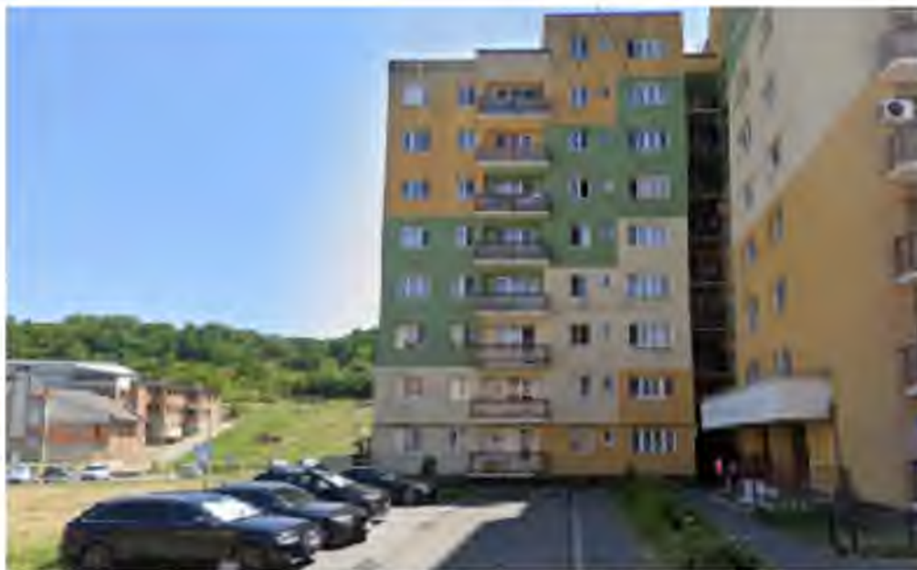
Zona reglementată prin PUD aprobat cu HCL nr. 232/2009. sursă: Google Earth
