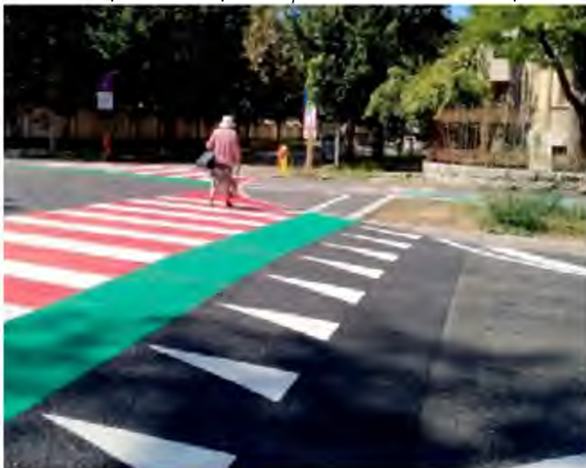
Exemple treceri de pietoni supraînălțate la nivelul pietonalului / iluminate cu panouri solare; Sursa: https://adevarul.ro/stiri-locale/timisoara/accidentele-rutiere-grave-s-au-injunatit-anul-2149106.html / https://ripostapenet.ro/2021/10/02/primaria-targoviste-sisteme-de-alimentare-cu-panouri-fotovoltaiice-la-trecerile-de-pietoni/
