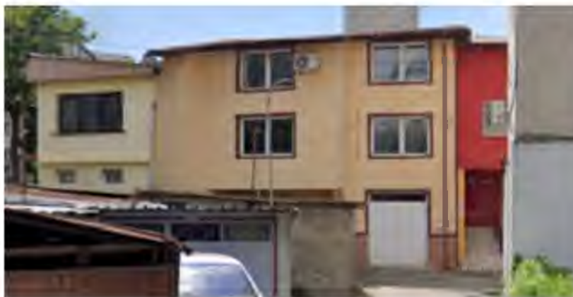
Zona reglementată prin PUD aprobat cu HCL nr. 270/2008. sursă: Google Earth
