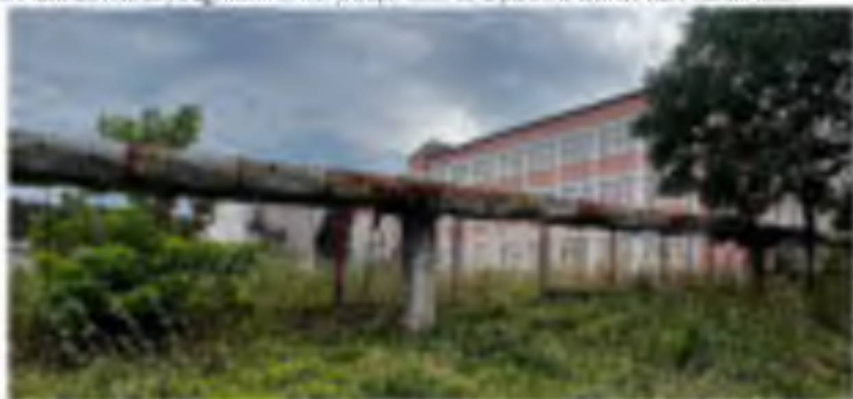
Conducte magistrale dezafectate; Sursa: autor
