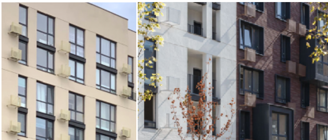
Exemplu de mascare a aparatelor de aer condiționat amplasate pe fațadă cu tablă perforată
