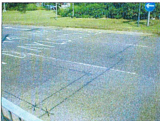
Figura 6 – Bucle inductive instalate în asfalt (exemplu)
