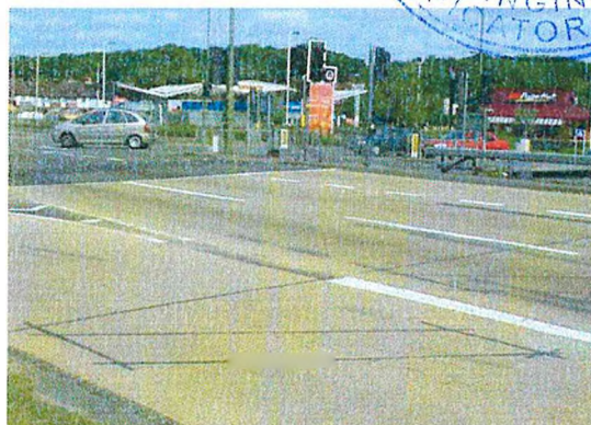
Figura 6 – Bucle inductive instalate în asfalt (exemplu)
