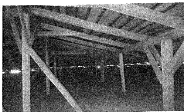
Elemente de acoperis subdimensionate, netratate, si rezemate direct pe termo-hidroizolatie existenta
