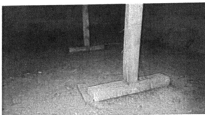
Elemente de acoperis subdimensionate, netratate, si rezemate direct pe termo-hidroizolatie existenta
