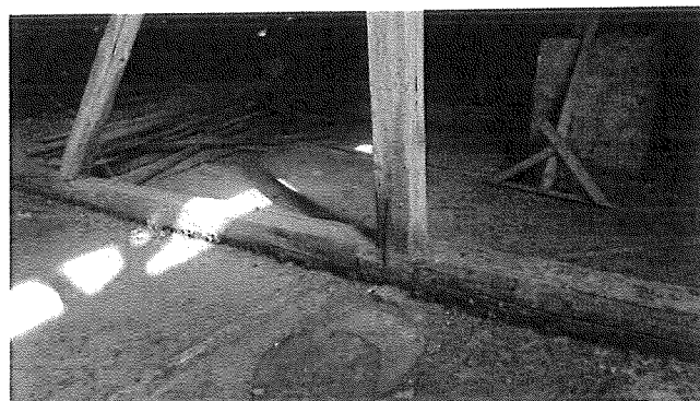
Lipsa ancorare talpi in elementele de beton ale structurii + asezare elemente de rezistenta ale sarpantei direct pe termo-hidroizolatie existenta (zgura + termoizolatie zgura + hidroizolatie)
