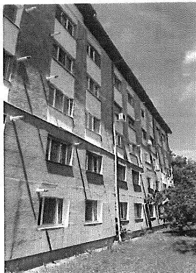
Fatada principala termoizolatii existente
